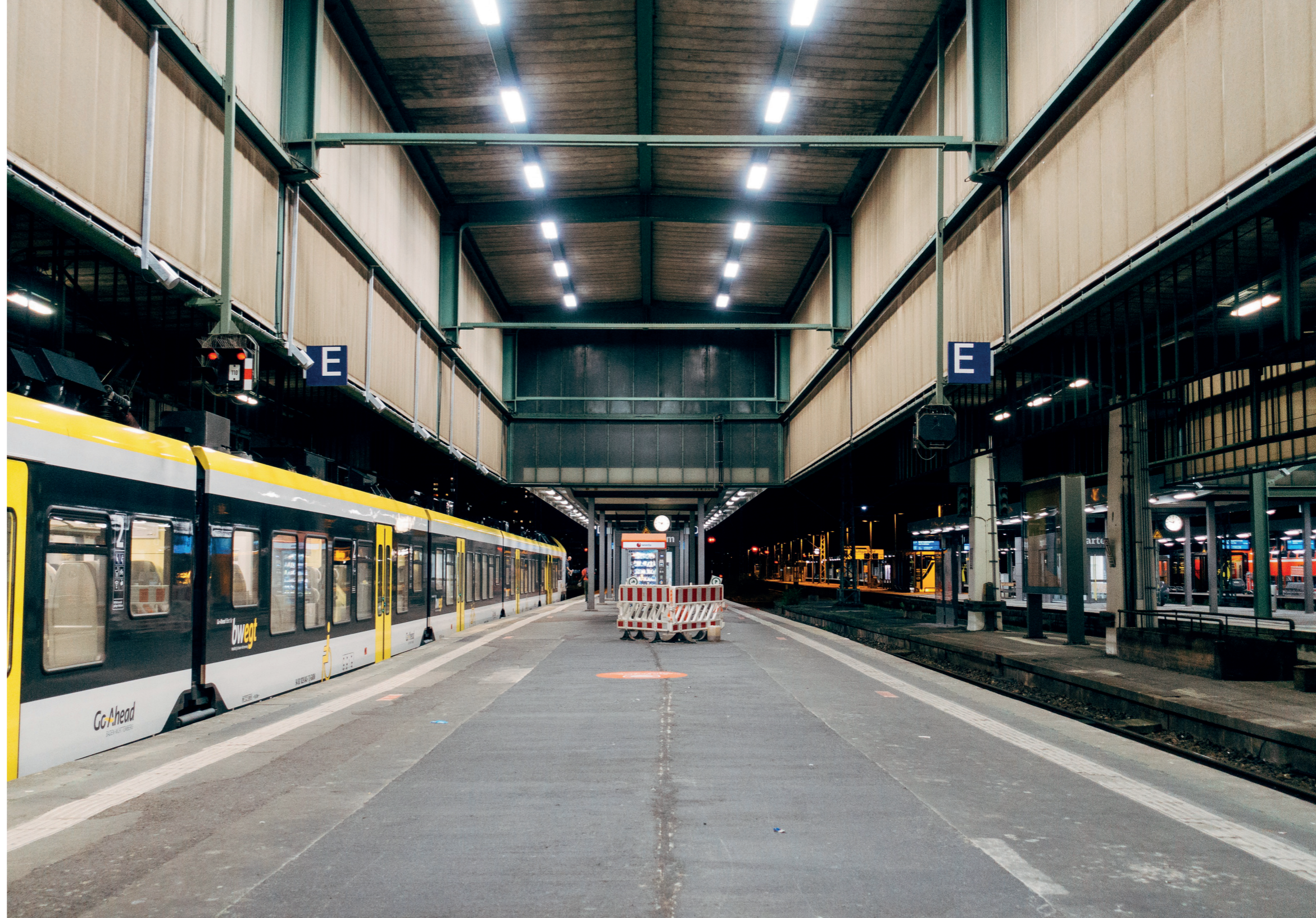
So sieht der Stuttgarter Hauptbahnhof aktuell aus.
