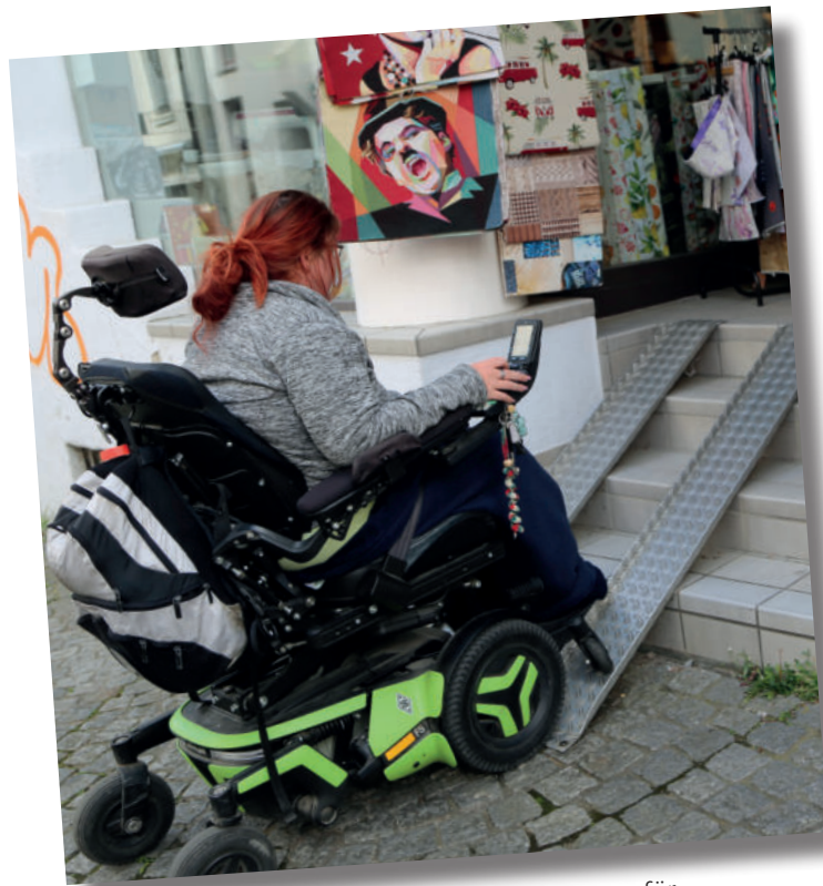
Die Rampe hilft zwar Menschen mit Kinderwagen, für Rollstuhlfahrer*innen ist die Steigung aber viel zu stark. Sie sollte nicht mehr als sechs Prozent betragen. Vor dem Nähzentrum drehen Romina Hipps Räder deshalb durch.
